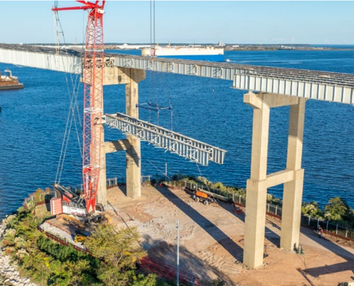
▲ Retirada de la primera viga de acero del lado sur del puente.
