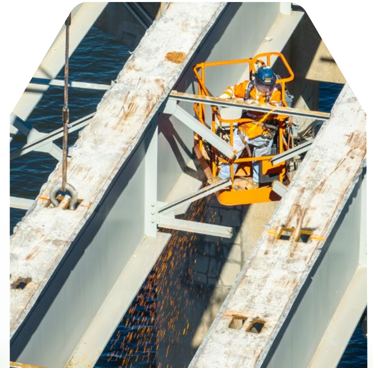
▲ Corte con soplete de las vigas de acero del lado sur del puente.
