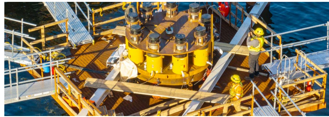
▲ El equipo instalando el sistema de gatos en un pilote de prueba.
