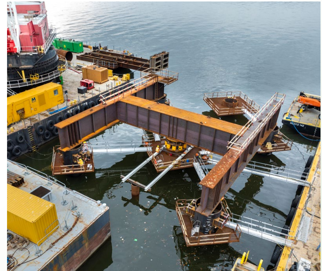
▲ El bastidor de carga colocado sobre los pilotes de prueba.
