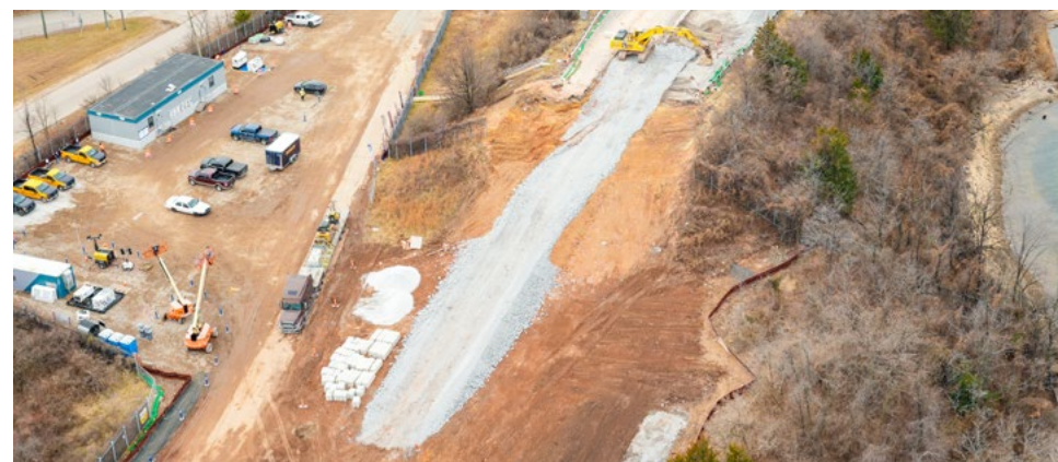
▲ Construcción de vías de acceso temporales.
