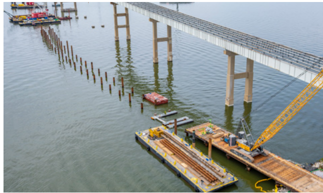
▲ Construcción de la pasarela en el lado norte.
