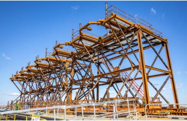
▲ Plantilla para hincado de pilotes.
